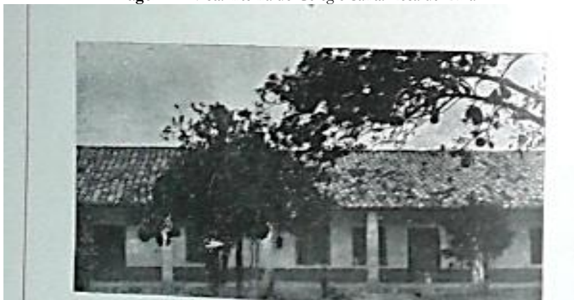
Imagem 2 - Vista interna do Colégio Santa Rosa de Lima
