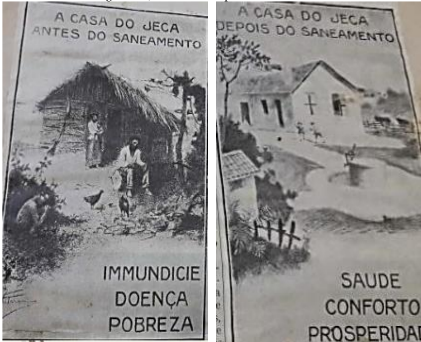
Figura 2 - Jeca antes e depois do saneamento
