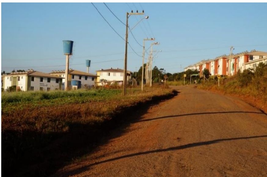
Figura 7 - Rua de acesso ao Loteamento Monte Castelo.
