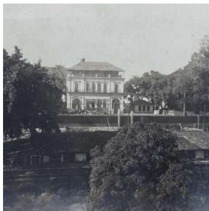
Antigo palacete (registro antes da demolição – 1938) – Repositório CEFET/RJ
