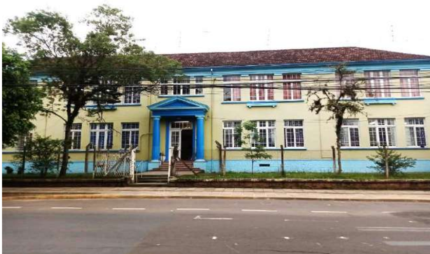
Fachada do Colégio Barbosa Rodrigues. Acervo Pessoal.
