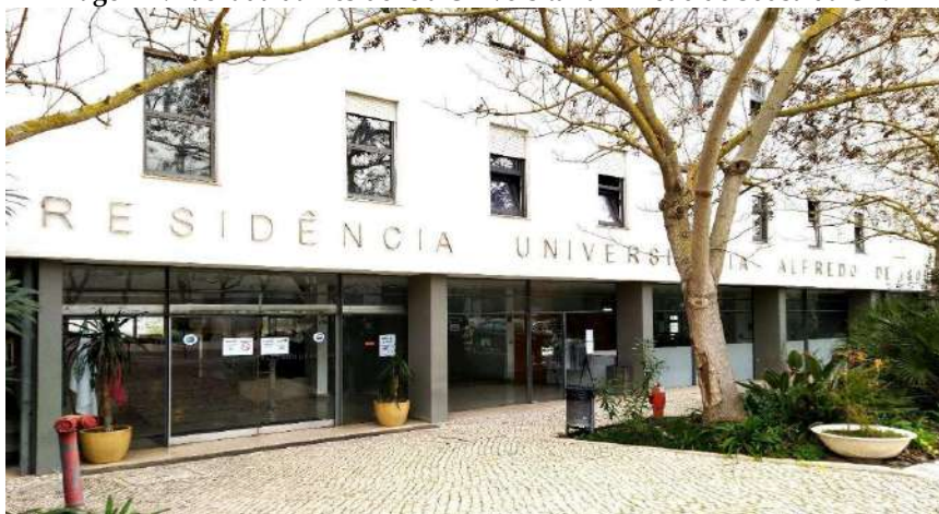
Imagem 1: Fachada da Residência Universitária Alfredo de Sousa da UNL
