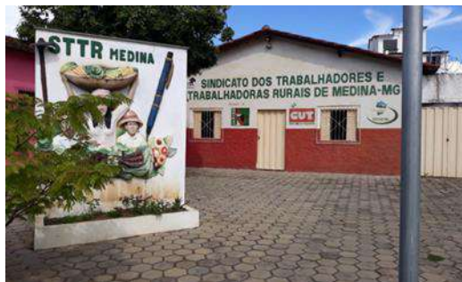
FIGURA 1 – FACHADA DO STTR DE MEDINA.
