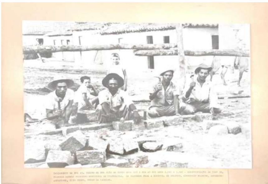
Calçamento da Rua 45 – trecho que vai da Rua João do Couto Rosa até a Rua 48 – 1961-1962
