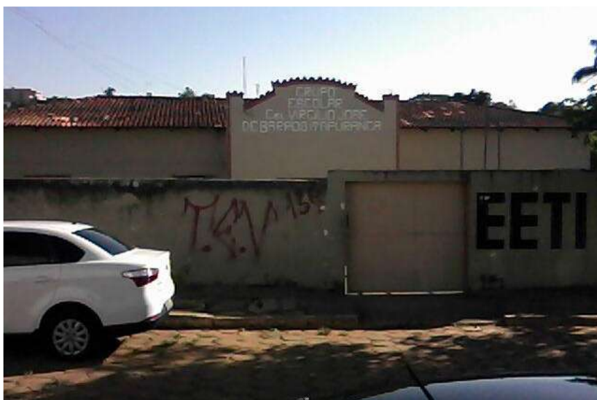
Frente da Escola Estadual Coronel Virgílio José de Barros, atualmente funciona a Escola Municipal. Rua 36 esq. com a 47. Fonte: Maria do Socorro Araújo Toledo e Nayara Cristina Gonçalves Rodrigues (2013)
