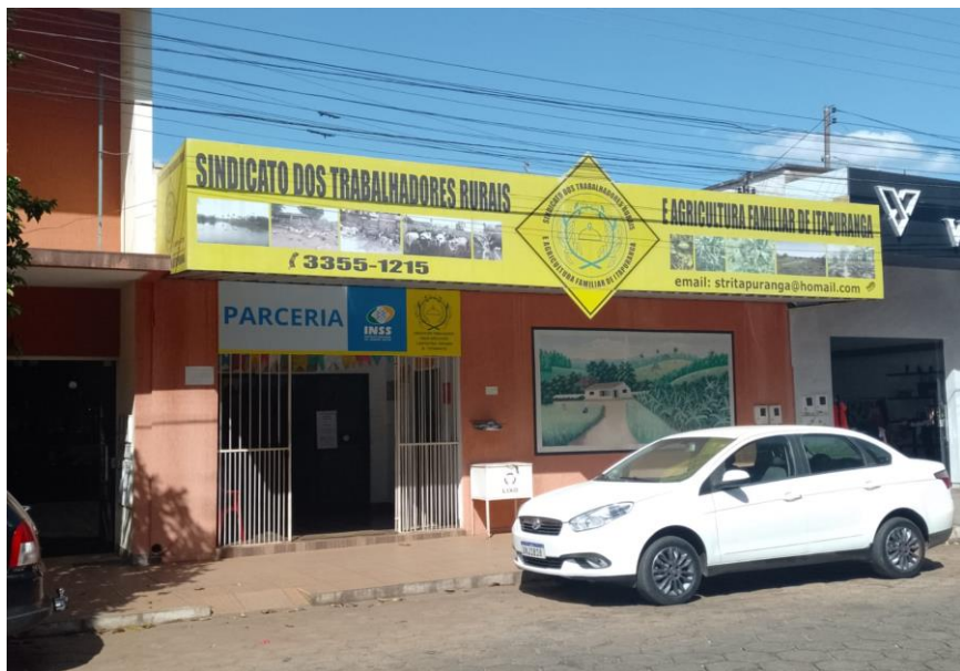
Fachada atual do Sindicato dos Trabalhadores Rurais de Itapuranga Fonte: Valtuir Moreira da Silva (2024)
