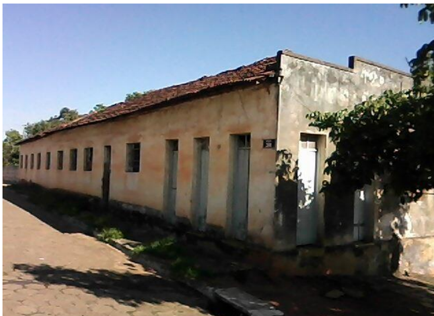
Antiga pensão Santo Antônio. Rua, 45, esq. com a 36. Prédio tombado como patrimônio para ser sede do Museu Histórico de Itapuranga Fonte: Maria do Socorro Araújo Toledo e Nayara Cristina Gonçalves Rodrigues (2013)
