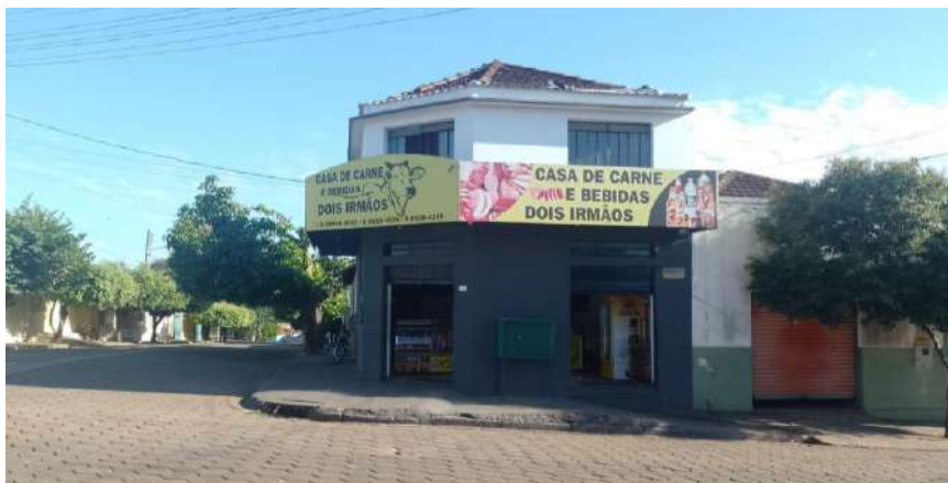
Local onde funcionou o Bar do Napoleão Importante ponto de encontro e comercial do Xixazão Fonte: Valtuir Moreira da Silva, (2024)
