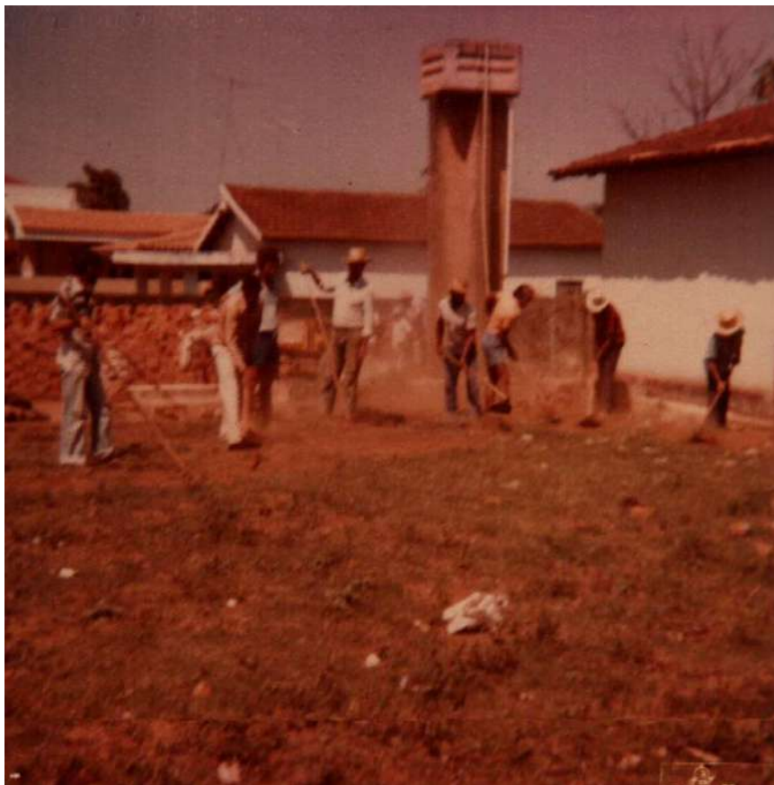
Terreno sendo preparado para construção do Salão Santos Dias do Sindicato dos Trabalhadores Rurais de Itapuranga – agosto de 1983
