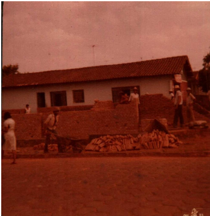
Construção do Salão Santos Dias do Sindicato dos Trabalhadores Rurais de Itapuranga
