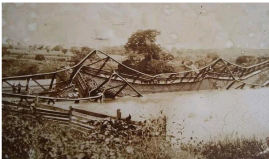
Imagem 18: A Ponte Metálica logo depois de desabar. Fonte: São José do Rio Pardo e suas histórias. Disponível em: https://sjrphistorias.com/2023/06/24/ponte-euclides-da-cunha/ . Acesso em: 5 de jul. 2024. .
