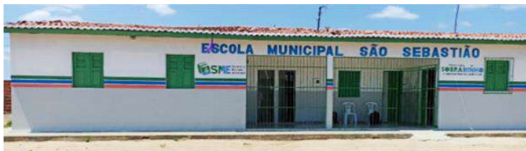
Figura 41 - Escola Municipal São Sebastião, em Lagoa Grande
