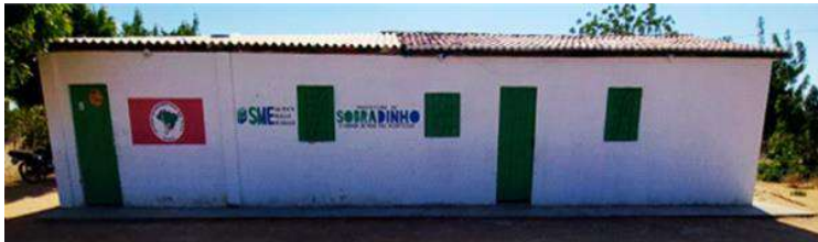
Figura 42 - Escola Municipal Ojefferson Santos Souza
