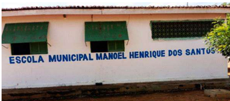
Figura 39 - Escola Manoel Henrique dos Santos (antes da reforma)
