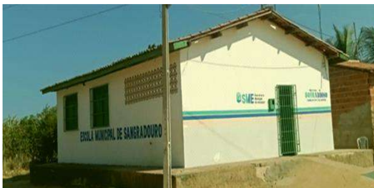
Figura 48 – Escola Municipal de Sangradouro
