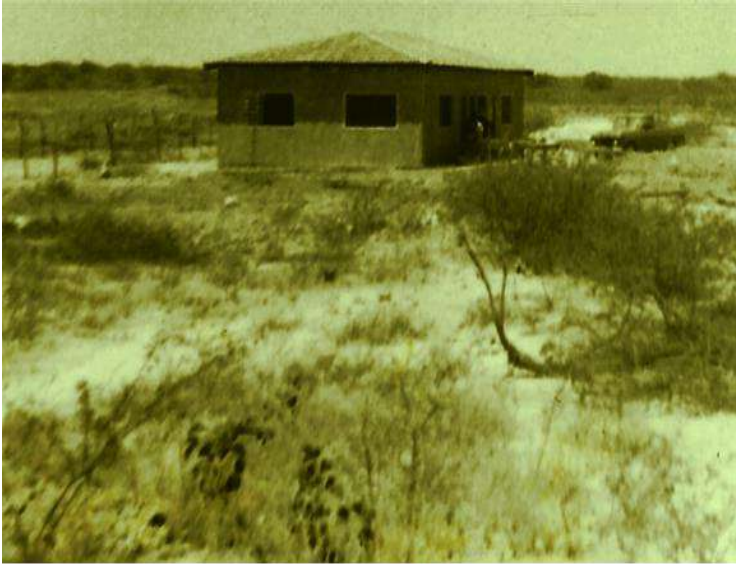
Figura 52 – Construção do primeiro pavilhão da EFAS
