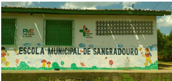
Figura 47 – Escola municipal de Sangradouro
