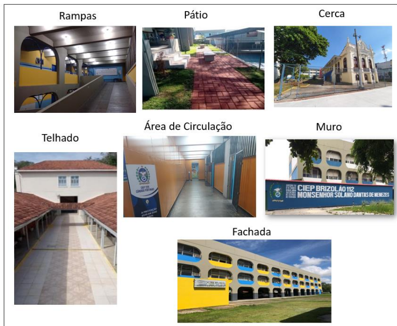
Figura 5: Pátio, Muro, Cerca, Rampas, Escadas, Área de circulação, Telhado e Fachada
