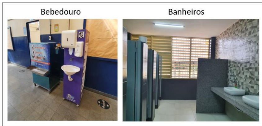
Figura 2: Imagens de Bebedouro e Banheiro após intervenções na infraestrutura
