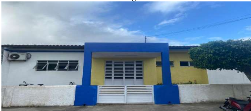
Figura 1 – Fachada do prédio provisório da Escola em Tempo Integral de Pedras de Fogo
