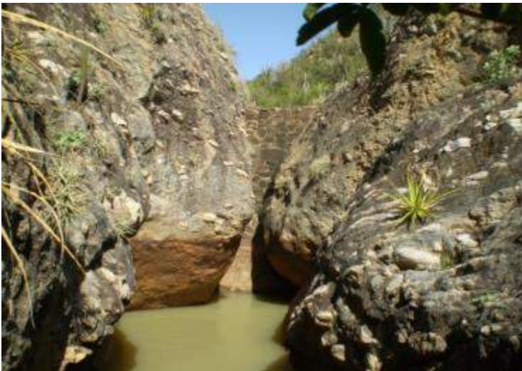
Figura 19 - Barragem edificada no cânion
