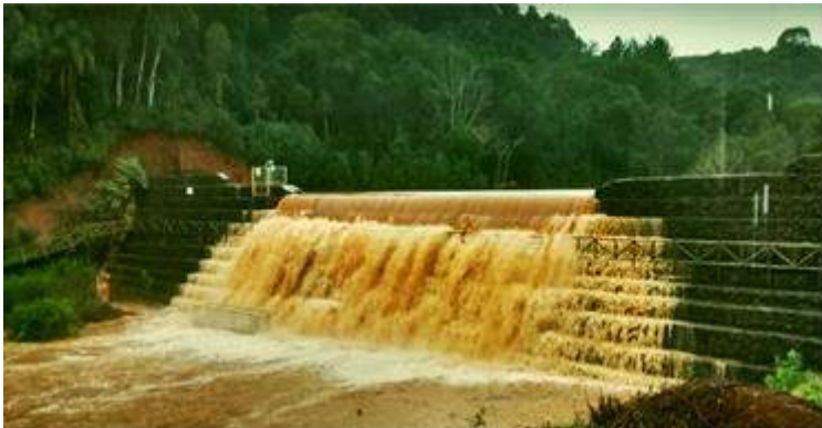
Figura 253 – Barragem de gabião, em operação
