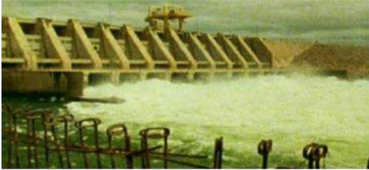
Figura 298 – Barragem de Sobradinho ainda sem canal para piracema
