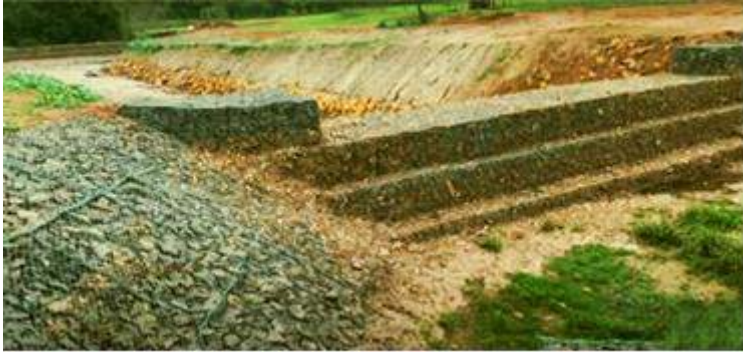
Figura 252 – Barragem de gabião, com soleira permeável
