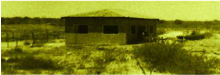
Figura 240 – Construção do primeiro pavilhão da EFAS
