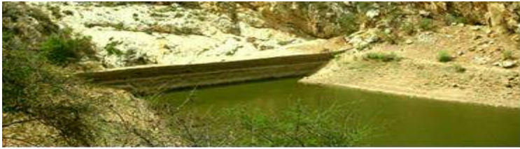
Figura 272 – Velha barragem, à montante do boqueirão
