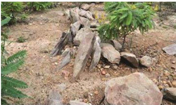
Figura 98 – Restos da barragem no leito do Rio São Lourenço
