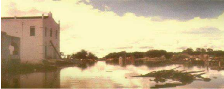
Figura 60 – Início da inundação
