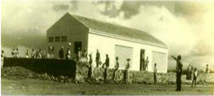
Figura 223 – Manoel Moura a orientar a construção do posto
