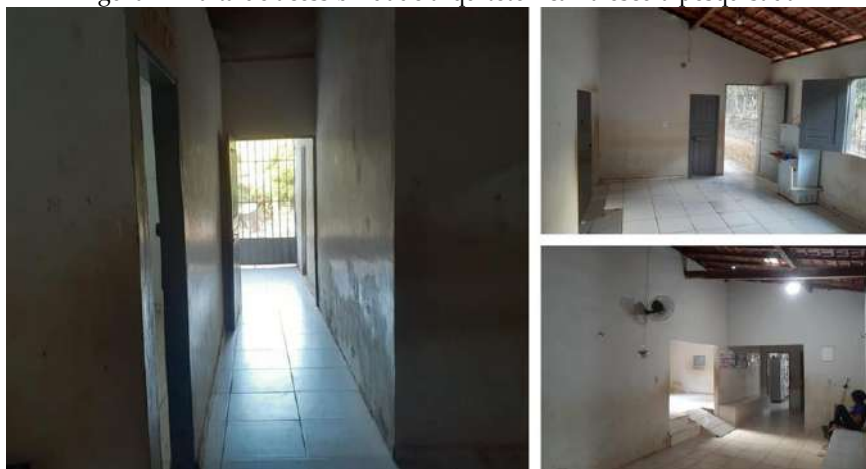
Figura 2 - Falta de acessibilidade arquitetônica na escola pesquisada
