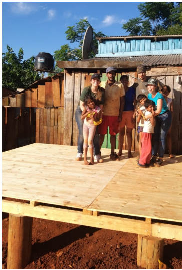
Figura 2: Primeiro dia Construção das fundações e do piso da casa.
