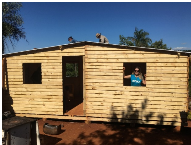
Figura 1: Habitação de emergência em fase de construção.
