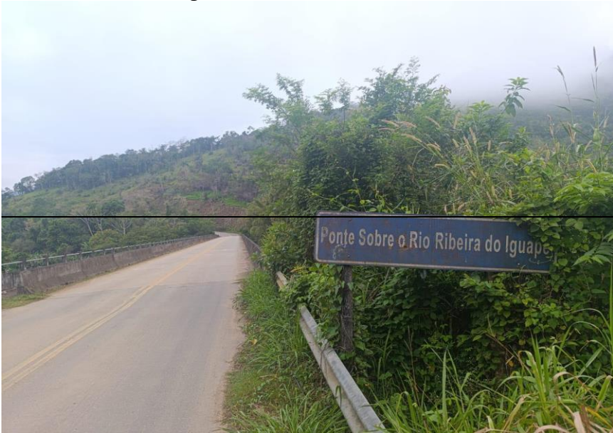
Figura 04: Acesso à comunidade
