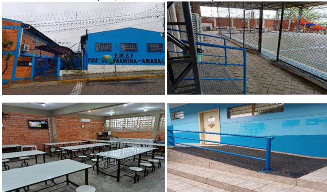
Ilustração 5, 6, 7 e 8: Prédio e instalações da escola
