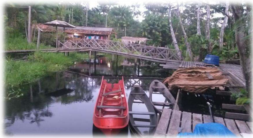
Figura 10 – Ponte entre a ponte principal de 600 metros e o Manejáí
