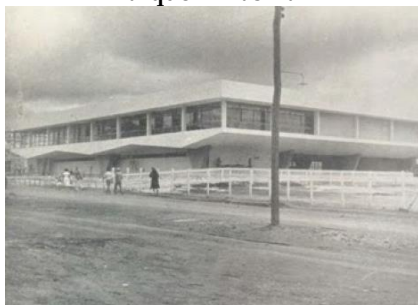
Imagem 01 - Construção da Escola Parque – Brasília
