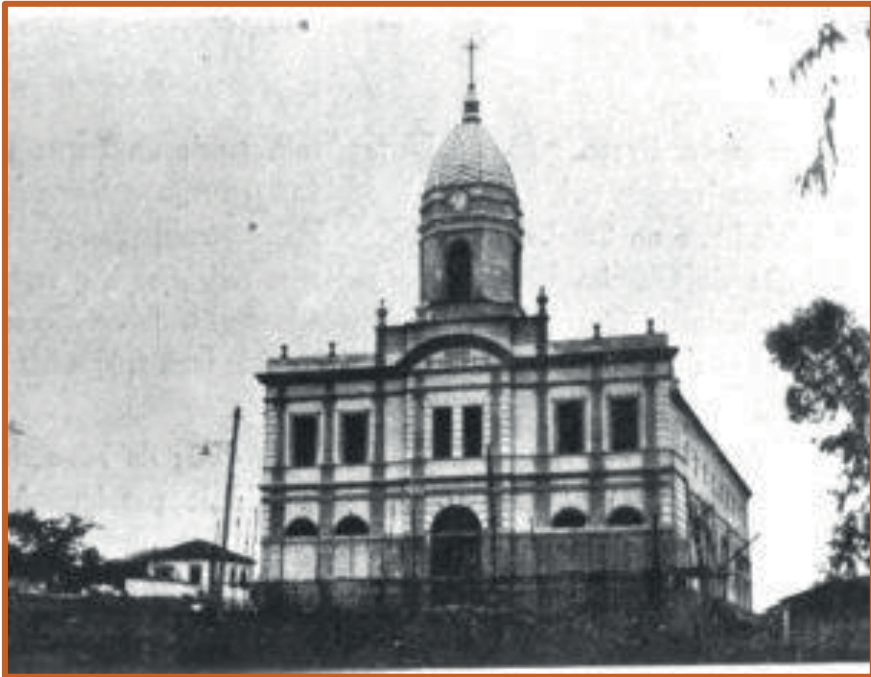
Imagem da primeira Matriz de Paraguaçu em construção.
