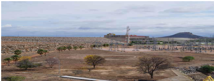
Figura 66 – Barragem de Sobradinho
