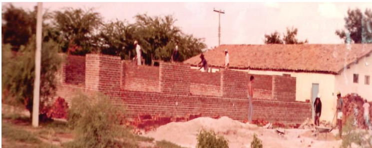
Figura 103 – Elevação das paredes do Centro Comunitário
