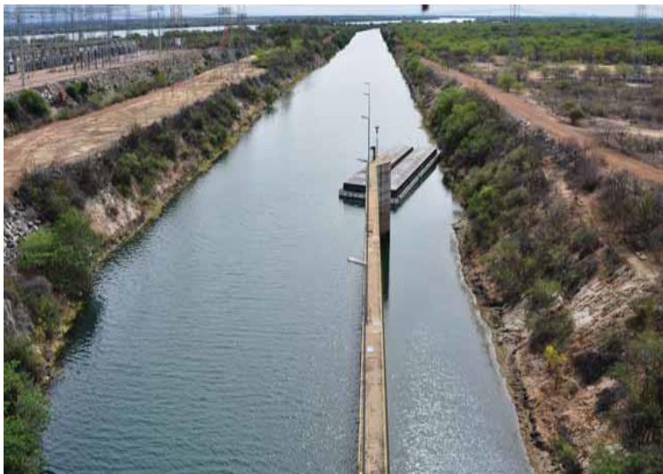
Figura 73 – Canal de aproximação da eclusa
