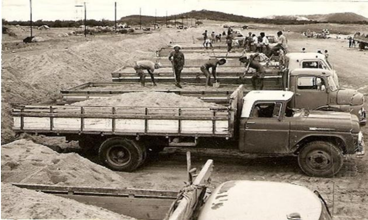
Figura 71 – Escavação para fundações da Barragem de Sobradinho
