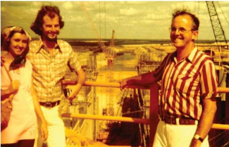
Figura 72 – Construção da eclusa e do canal de aproximação
