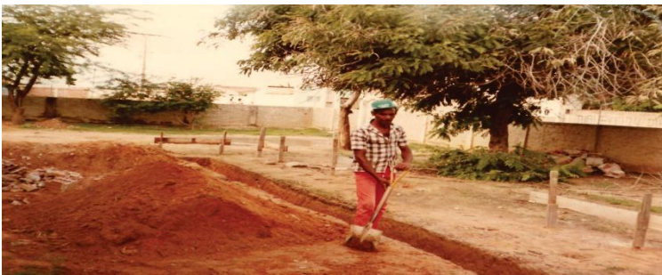
Figura 100 – Escavação das fundações do Centro Comunitário
