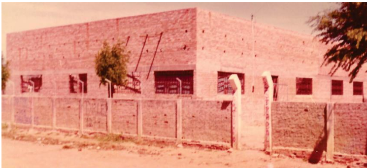
Figura 105 – Paredes levantadas do Centro Comunitário
