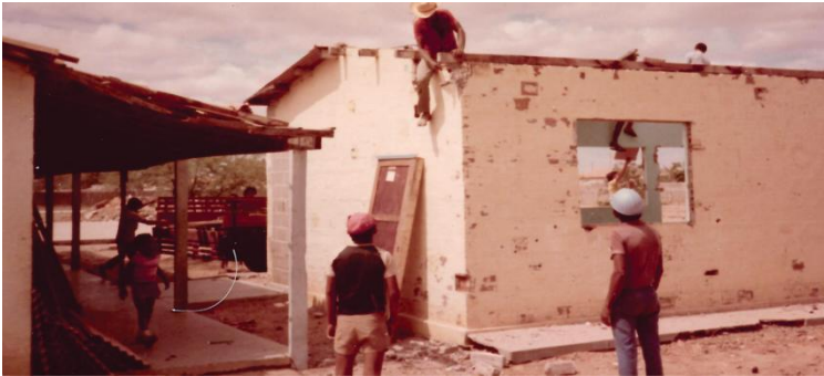
Figura 98 – Demolição dos galpões
