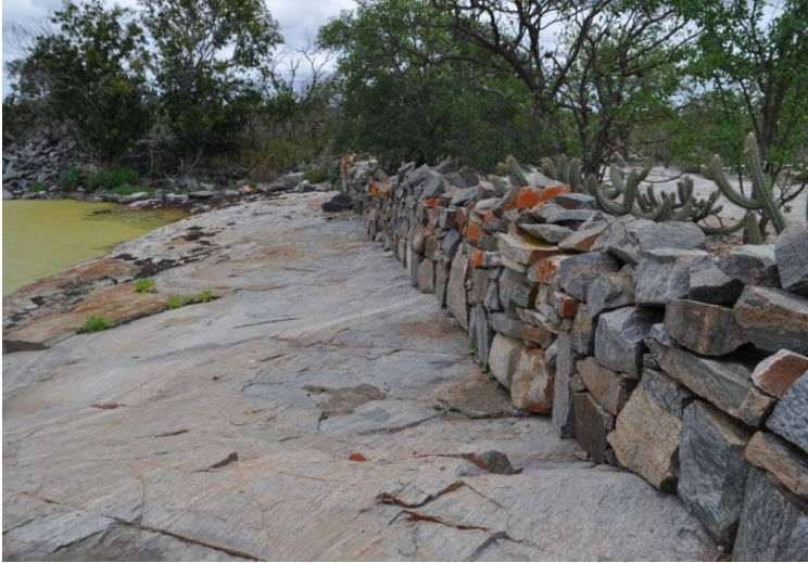
Figura 339 – Muro de pedra em torno do centenário caldeirão
