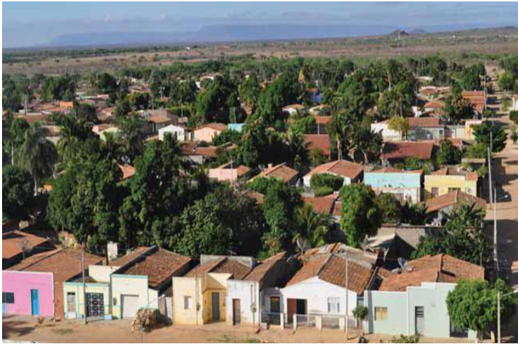
Figura 78 – Vista parcial da Vila São Joaquim
