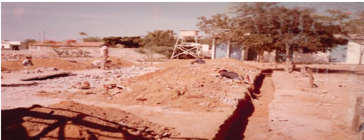
Figura 99 – Escavação das fundações do Centro Comunitário
