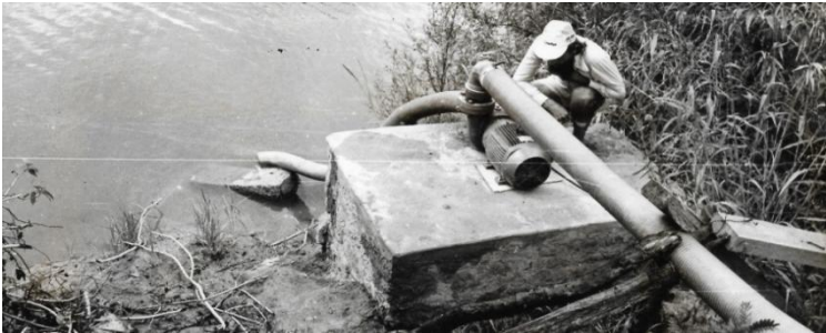
Figura 86 – Instalação da eletrobomba conquistada com greve
