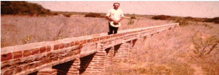
Figura 26 – Aqueduto de arquitetura vernácula
