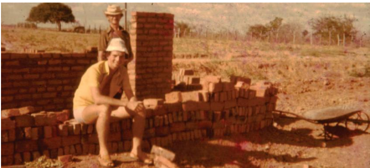
Figura 24 – Casa rural em construção no povoado de Itacoatiara
