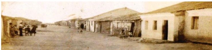
Figura 2 – Entrada da Aldeia Tuxá, em Rodelas
