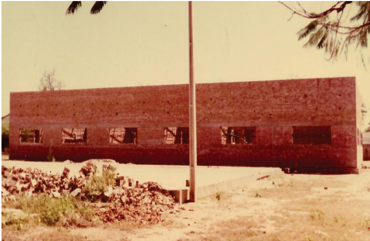
Figura 104 – Paredes levantadas do Centro Comunitário
