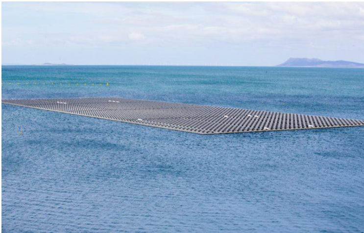
Figura 287 – Energia fotovoltaica gerada no Lago de Sobradinho
