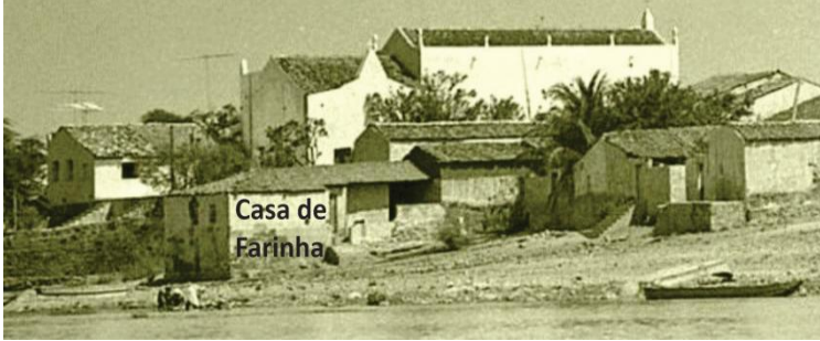
Figura 130 - Casa de farinha edificada junto ao Rio São Francisco
