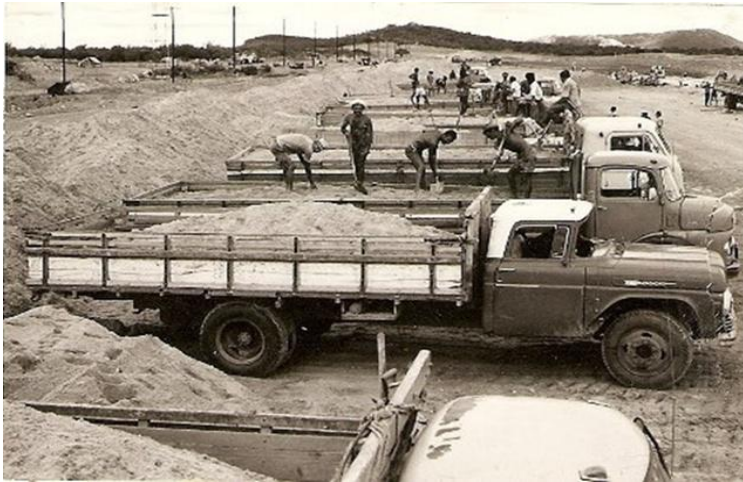
Figura 192 – Escavação para fundações da Barragem de Sobradinho
