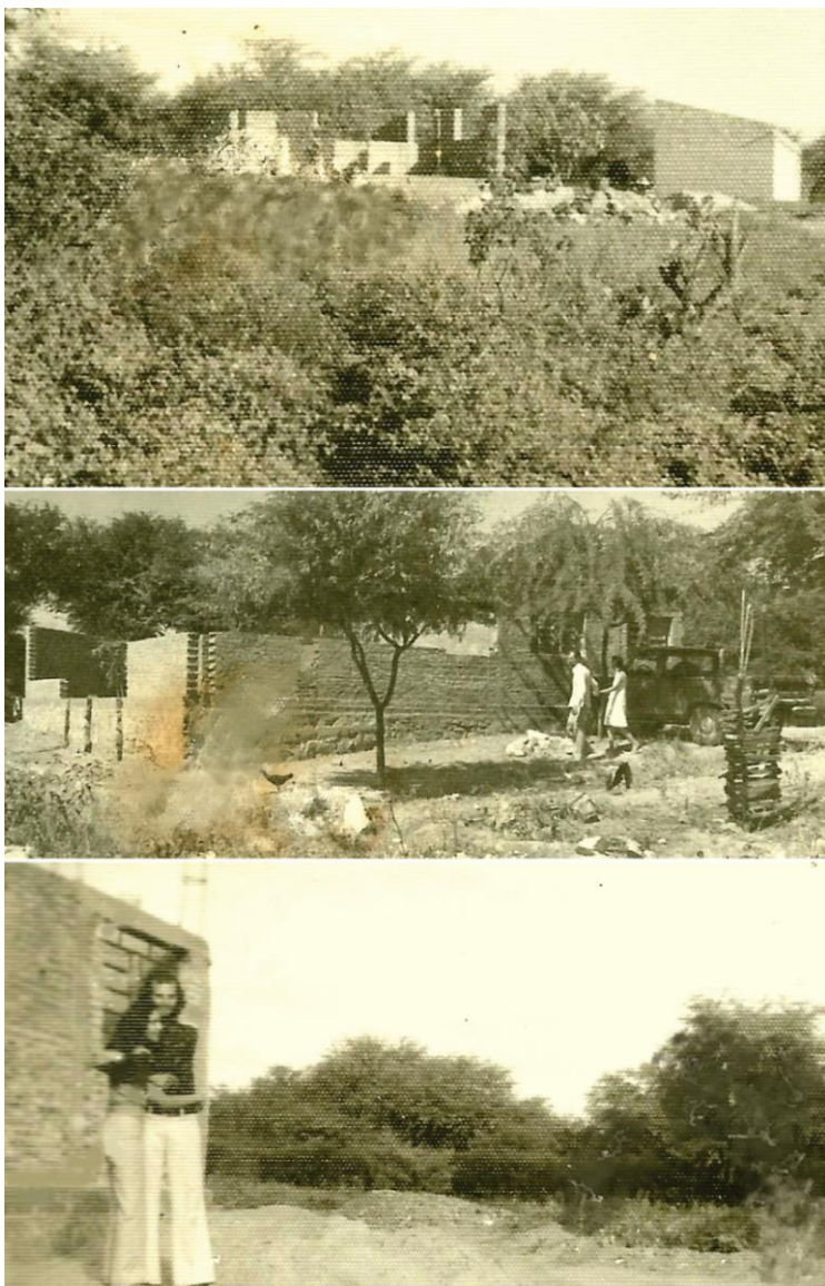
Figura 167 - Nossa residência em construção e, enfim, habitável
