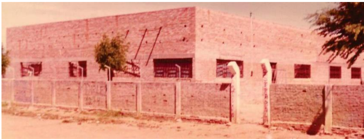
Figura 220 – Centro Comunitário em construção
