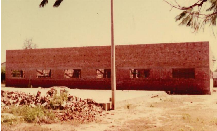
Figura 219 – Construção do Centro Comunitário
