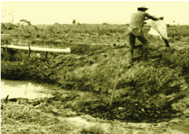
Figura 197 – Implantação do canal de irrigação artesanal
