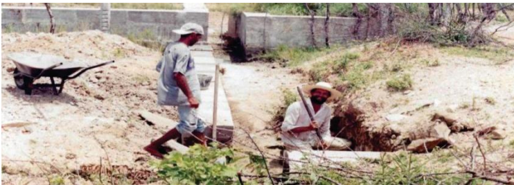
Figura 235 - Edificação de infraestrutura para armazenar de água
