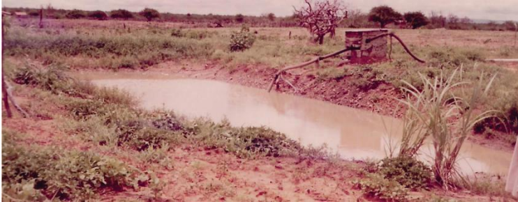
Figura 215 - Sistema de irrigação, com rústica casa de bomba
