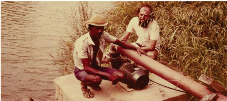
Figura 200 - Instalação da eletrobomba
