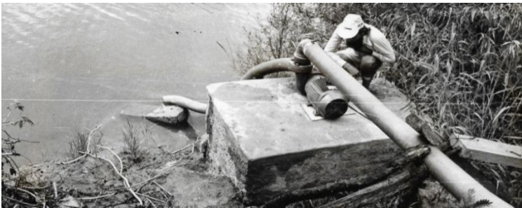
Figura 199 – Instalação da eletrobomba conquistada com greve
