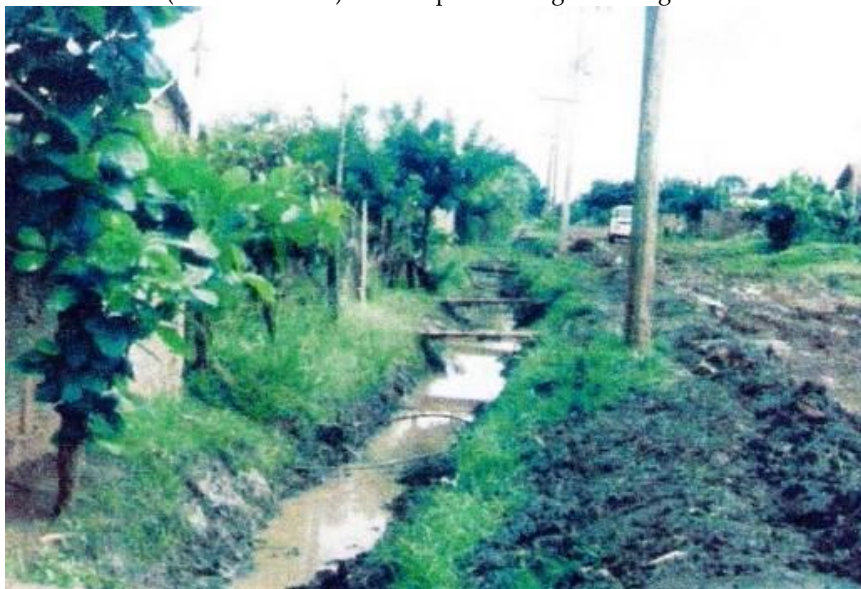
Figura 44 – Vila Cachoeirinha (década de 1990): valetas para drenagem das águas
