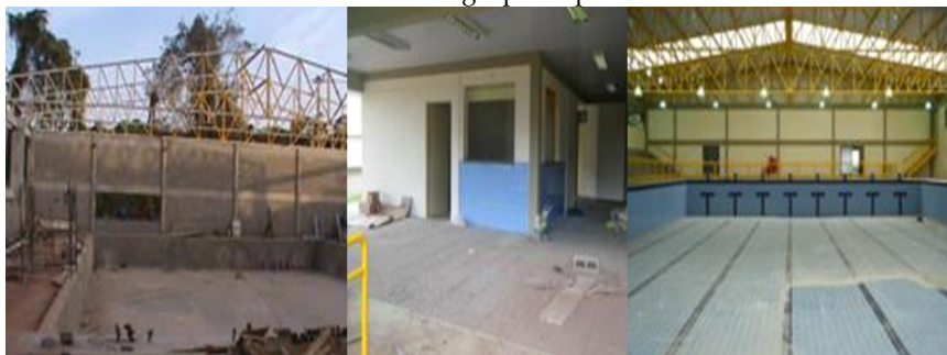
Figura 14 - Fotos da construção do Laboratório Didático de Esportes Aquáticos do Departamento de Educação Física da UNESP-Bauru. No espaço há uma piscina semiolímpica adaptada, com rampa de acesso para baixa mobilidade e PCD, facilitando projetos de extensão universitária, que atendem essa população PCD e outros grupos especiais.
