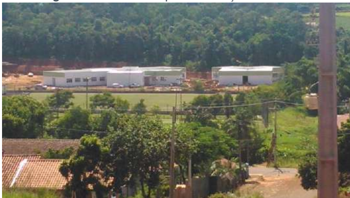
Figura 6: obra do câmpus em março de 2015
