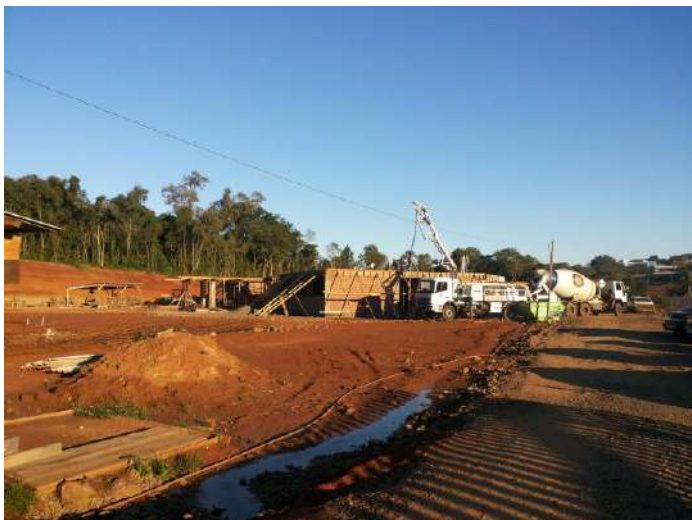
Figura 4: imagem das obras de implantação do Câmpus Lajeado
