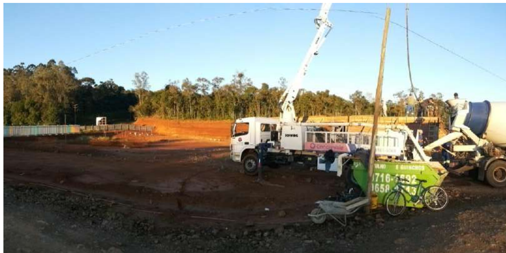
Figura 5: imagem das obras de implantação do Câmpus Lajeado
