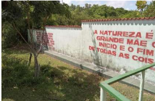
Figura 9- Muro da frente do Instituto Caruanas
