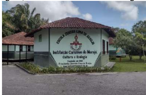
Figura 7- Salas de aula em formato hexagonal.
