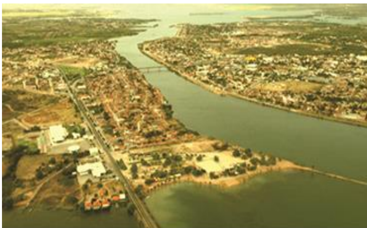
Figura 8- Canal que se abriu para o reservatório da Usina PA-4
