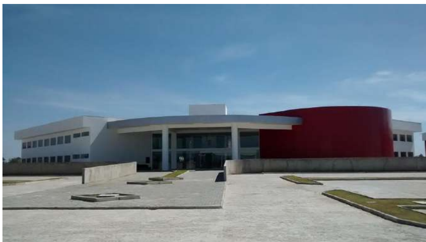
Foto: Vista do prédio administrativo do IF Baiano Campus Serrinha (2016).
