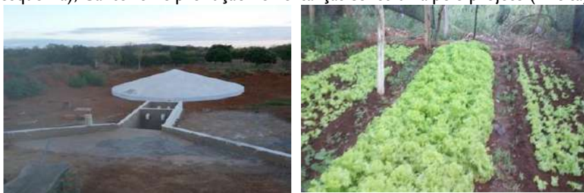
Figura 7. Cisterna de captação de água de 52 mil construída pelo projeto (esquerda); Canteiro de produção de hortaliças construída pelo projeto (direita)
